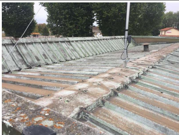
Déclaré - : TOITURE - Plaque- (Absence d'amiante)
