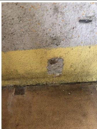
Prélèvement - P005 : RDC / LOCAL 01 - Enduit lissé- (Absence d'amiante)
