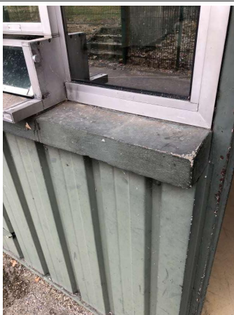
Prélèvement - P007 : FACADES - Enduit lissé- (Absence d'amiante)
