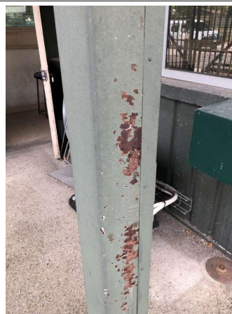
Prélèvement - P008 : FACADES - Peinture- (Absence d'amiante)
