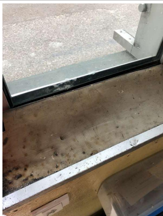
Prélèvement - P001 : RDC / LOCAL 01 - Revêtement plastique épais- (Absence d'amiante)
