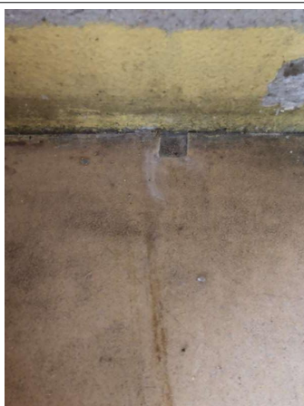
Prélèvement - P003 : RDC / LOCAL 01 - Lé plastique- (Absence d'amiante)
