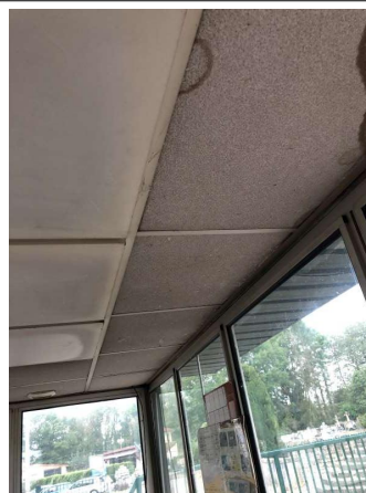
Prélèvement - P006 : RDC / LOCAL 01 - Faux plafond- (Absence d'amiante)
