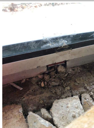
Prélèvement - P004 : RDC / LOCAL 01 - Joint d'étanchéité entre menuiserie et structure- (Absence d'amiante)
